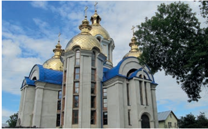
BUDOWA CERKWI ŚW. ARCHANIOŁA MICHAŁA PRZY UL. SOROCHEJA
