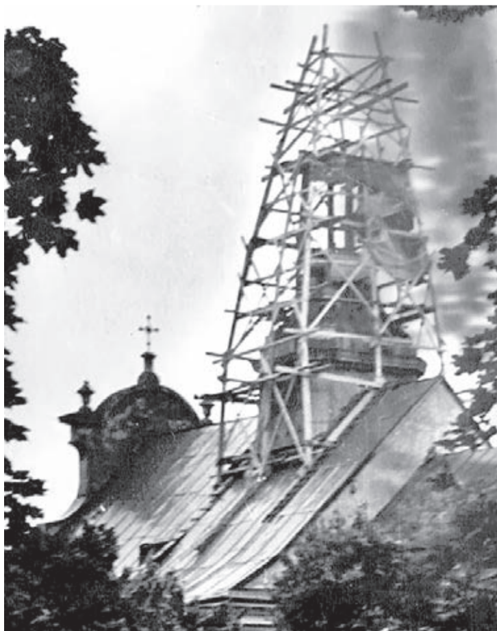
REMONT WIEŻY KOŚCIOŁA ŚW. ANTONIEGO WE LWOWIE
