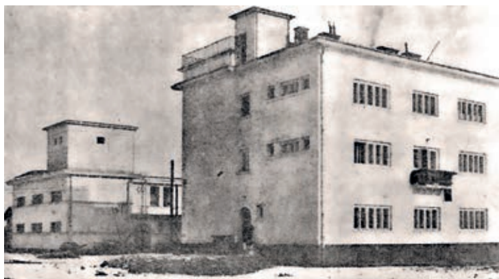
SALA MASZYN I BUDYNEK ELEKTROWNI MIEJSKIEJ
