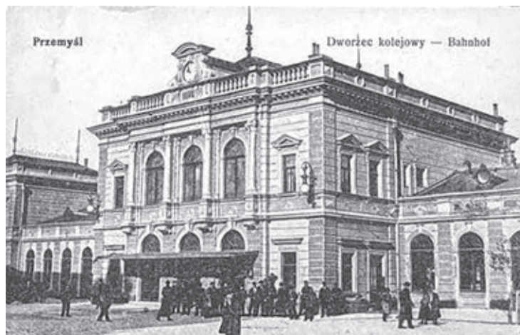
DWORZEC KOLEJOWY W PRZEMYŚLU
