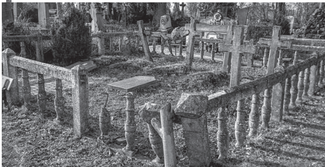
STAN KWATERY BELGIJSKIEJ NA CMENARZU MIKULINIECKIM PRZED RENOWACJĄ
