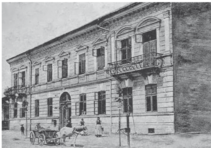
Budynek wiejskiej bursy
