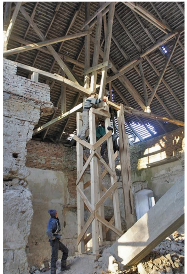
Prace przy zabezpieczeniu więźby dachowej zamku
