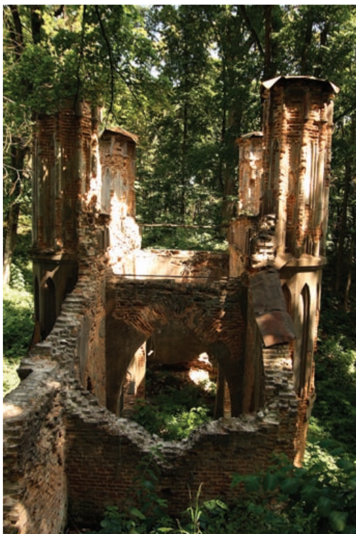
Ruiny neogotyckiego mostu w Sokiryńcach
