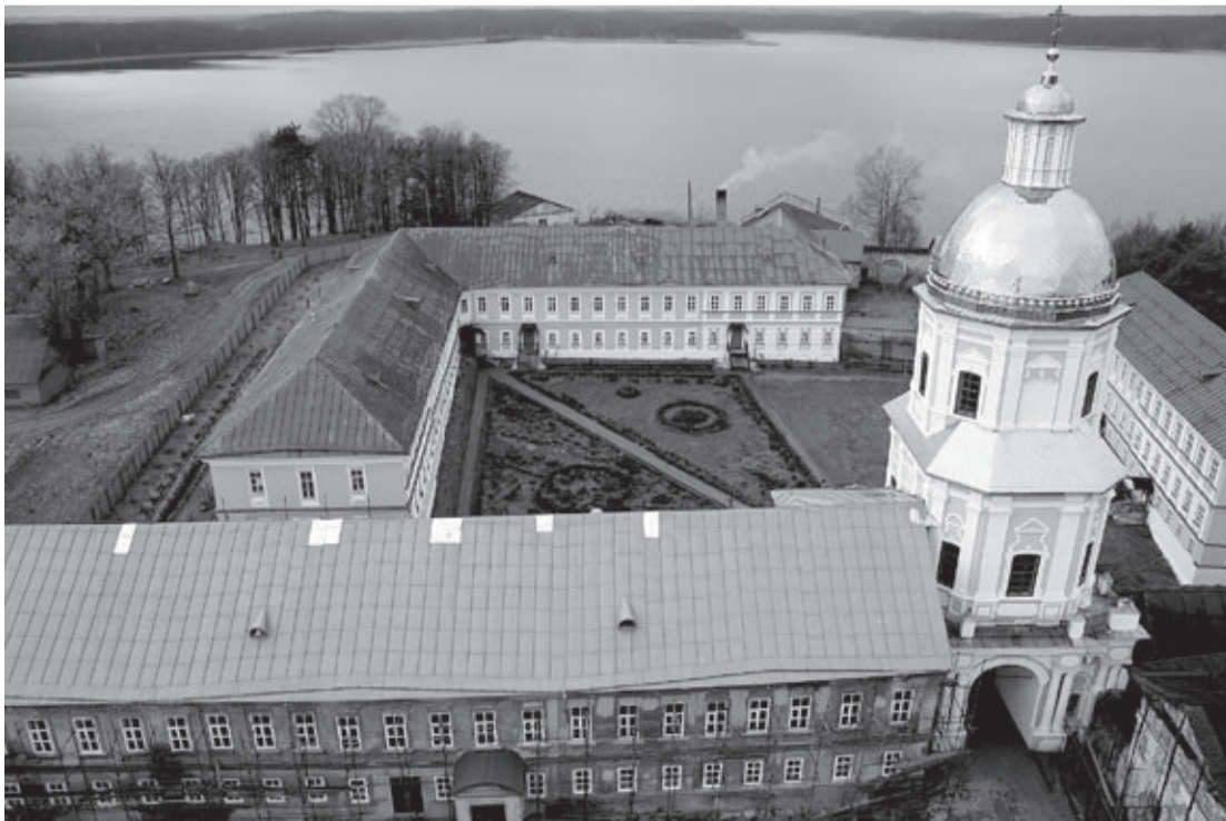
Monaster „Niłowa Pustelnia”, widok obecny
