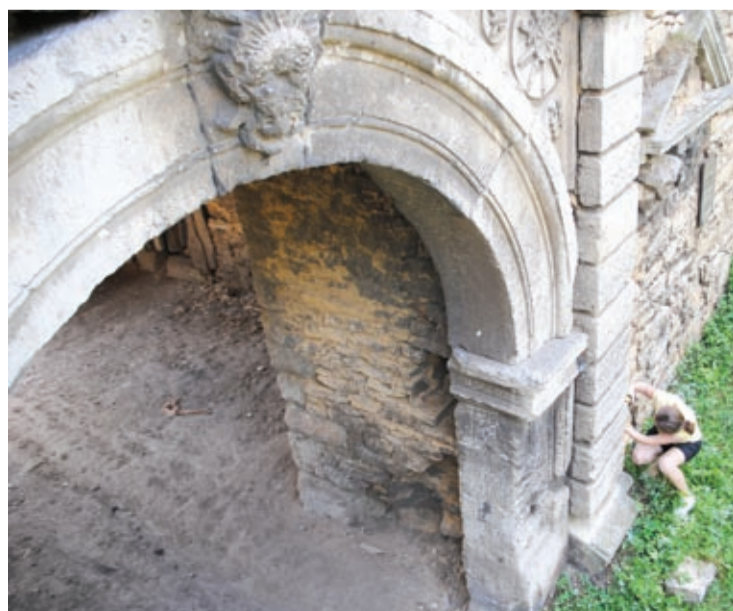
Prace przy bramie wjazdowej
