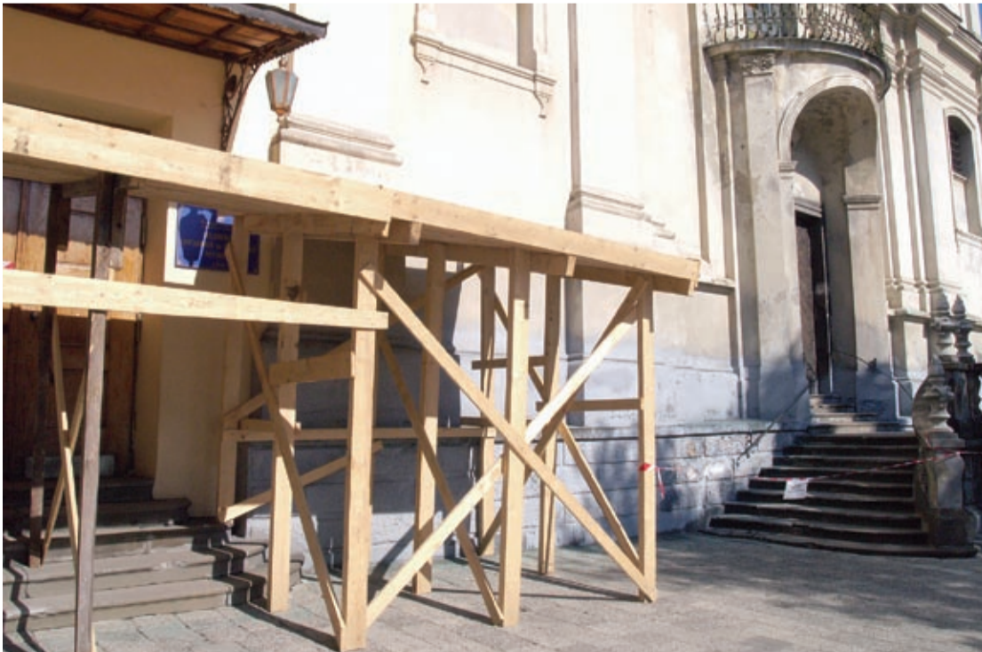
Rusztowania przy jedynym wejściu do kościoła, marzec 2012 r.
