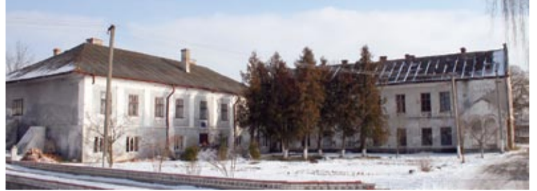
Budynki dawnego powiatowego szpitala, kiedyś pracowała tu błogosławiona Marta Więcka
